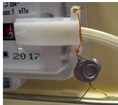
Рис. 4 - Место пломбирования датчика импульсов.
